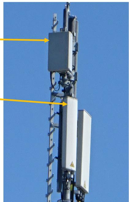
Während die Messung von 5G „Wide“-Signalen mit den konventionellen Sektorantennen relativ einfach ist und weitgehend der LTE-Messung entspricht, stellt die Messung von 5G Fast wegen des aktiven Beamformings ganz besondere und neue Herausforderungen an Messtechnik und Messmethoden, vor allem wenn es um die Bestimmung der maximalen Immission geht.
